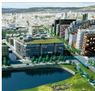
Eufemias kontorbygg, Oslo
